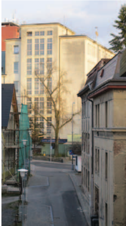
Oskar Baudisch: realizovaná podoba pavilonu chirurgie pohled z ulice Bernardova (foto Archiv autora, 2015).
