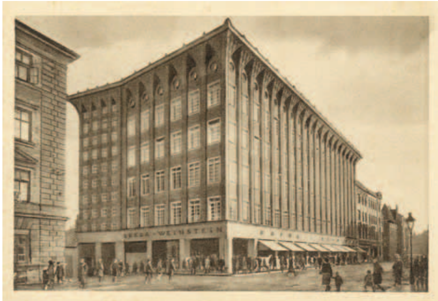
Leopold Bauer, obchodní dům Breda & Weinstein v Opavě, 1927–1929 (dobová pohlednice, sbírka autora).
