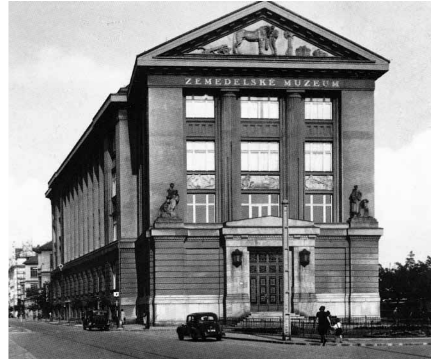
Pôvodná budova Zemeľského múzea, dnes Slovenského národného múzea (1924–1928), od architekta Milana Michala Harmince (Archív architektúry, Oddelenie architektúry HÚ SAV).
